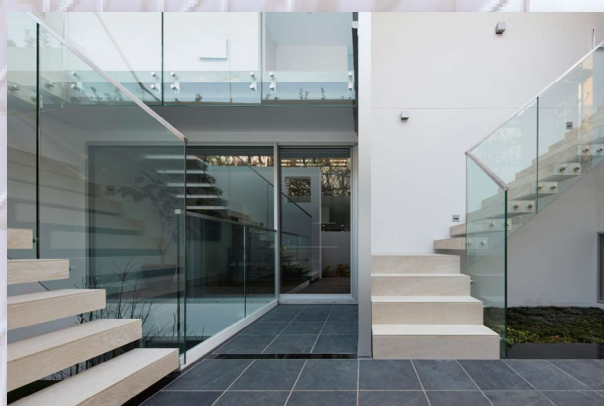
SAKURA SAKURA SAKURA 新築工事
