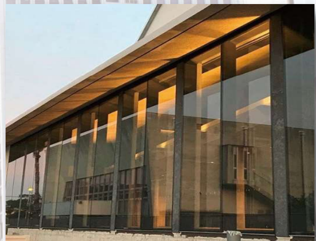
阿久根市民交流センター建設工事
