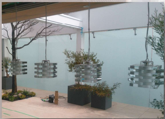
VILLA on the park 新築工事
