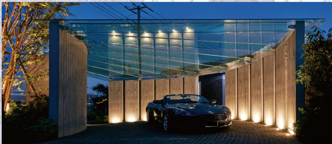
流山 Alfa Flat 新築工事
