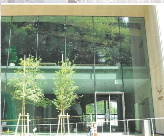
飯山ぶらざ新築工事(長野県飯山市)
