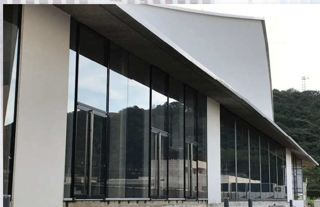
阿久根市民交流センター建設工事
